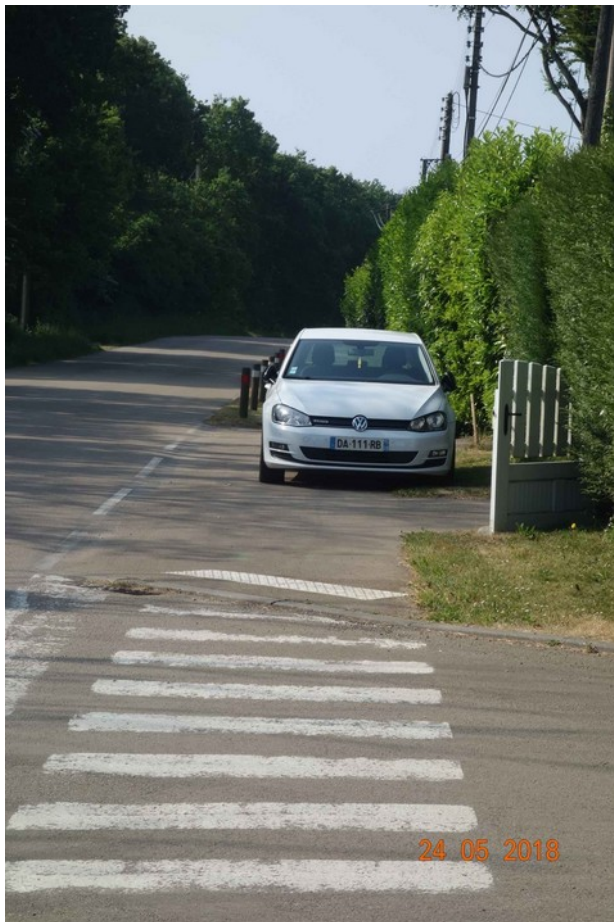
Piste cyclable (voie verte ??) du Pillion : piste empruntant un passage piéton, ligne de stop gênante, pas d'indication de piste cyclable pour les usagers de la voie sécante, bordure « fil d'eau » non perpendiculaire et non effacée, stationnement très gênant... la totale !
